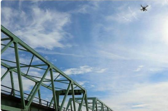
現在は橋梁を中心に損傷箇所検出システムの開発を進めています。将来的にはコンクリートや鋼材を含んださまざまな巨大建造物の点検への展開も行っていきます。ただ、点検とひと口に言っても確認すべき点は多岐にわたります。たとえば橋梁の場合は橋脚のひびや橋桁の損傷、各ブロックのコンクリートや金属の状態などをそれぞれチェックする必要があります。上に道路がある場合は路面部分の点検も必要です。橋梁だけでもこれだけ確認箇所があるので、より多くの建造物を点検するとすれば、ひとつずつノウハウを蓄積する必要があると言えます。
